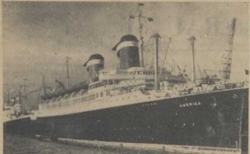
Die „America“ ist zurzeit der größte Passagierdampfer, der deutsche Häfen anläuft. Sie umfaßt 33 500 BRT, und hat eine Länge von 220 Meter und eine Breite von 28 Meter. Ein Schornstein ist nur Atrappe. Bilder: SZ
