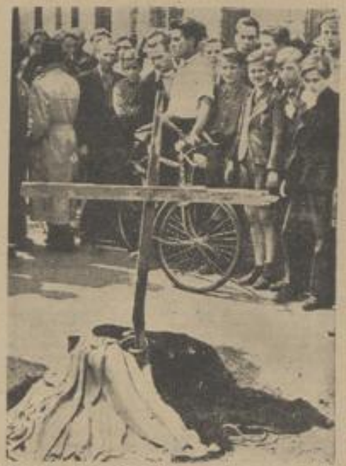
Das erste Opfer der Demonstrationen in Berlin war ein Ostberliner Eisenbahner, der am Alexanderplatz von einem sowjetischen Panzerspähwagen, der in die Menge hineingerast war, überfahren worden war. An der Stelle seines Sterbens errichteten die Berliner ein schlichtes Holzkreuz.
