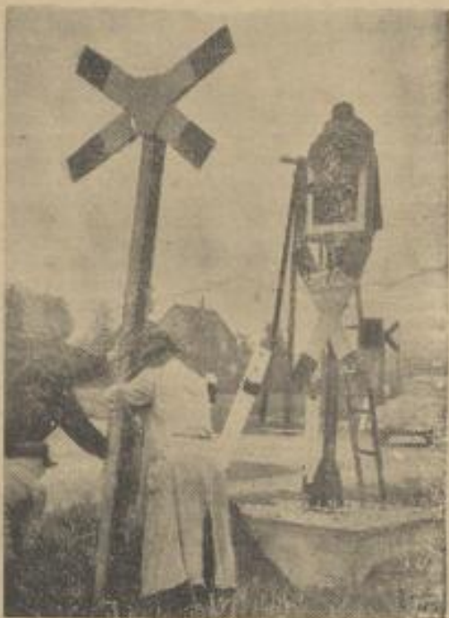
Die Deutsche Bundesbahn stellt zurzeit an bisher unbeschränkten Bahnübergängen neuartige „Haltlichtanlagen“ auf. Bei diesen neuen Anlagen entfällt das weiße Blinklicht ganz. Bei der Annäherung eines Zuges leuchtet jedoch das rote Warnlicht auf. Im Betrieb blinkt das rote Licht pro Minute sechszigmal. Dadurch, daß die Warnlichtanlage automatisch von dem die Strecke befahrenden Zug eingeschaltet wird, ist die Unterbrechung des Straßenverkehrs an unbeschränkten Bahnübergängen auf ein Minimum herabgesetzt. Unter der Lichtanlage ist ein hochgestelltes Warnkreuz angebracht. Unter Bild: Eine neue Haltlichtanlage wird ihrer Bestimmung übergeben. Das bisherige Warnkreuz (links) wird entfernt.
