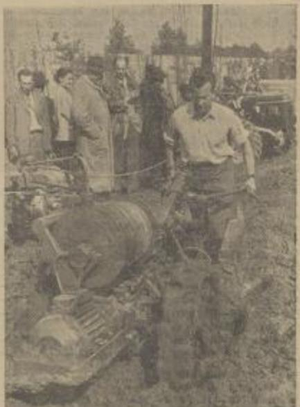
Siemens bringt die Elektroenergie auch auf den Acker. Der neue Elektropflug ist mit einem 5-Kilowatt-Drehstrommotor ausgerüstet. Das Gummikabel, das den Motor mit Strom versorgt, rollt sich selbsttätig auf eine Trommel auf bzw. von dieser ab. Auch zu dieser neuartigen Antriebsmaschine gibt es eine ganze Reihe Anhängergeräte.
