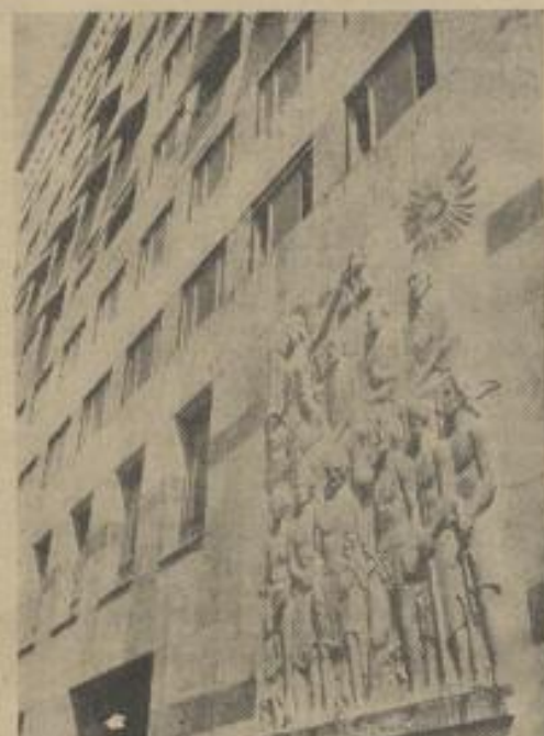
Das ist das Stuttgarter Justizhochhaus, über das wir bereits eingehend berichtet haben. Am Mittwoch fiel die Hülle von dem Relief neben dem Haupteingang. Der Bildhauer Ernst Kress hat hier eine symbolische Gruppe geschaffen, unter der (in der oberen Reihe von links) die Köpfe von Oberlandesgerichtspräsident Dr. Perlen, Ministerpräsident Dr. Maier und dem früheren Justizminister Dr. Beyerle verewigt sind
