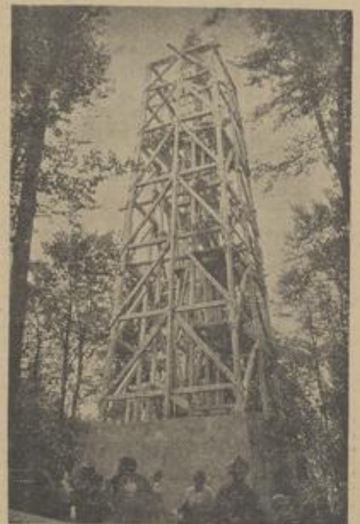
Auf dem Sternberg bei Gomadingen, dem schönsten Aussichtspunkt der Münsinger Alb, steht jetzt das Holzgerüst des neuen Aussichtsturms. Am vergangenen Donnerstag wurde vom Schwäbischen Alverein Richtfest gefeiert...
