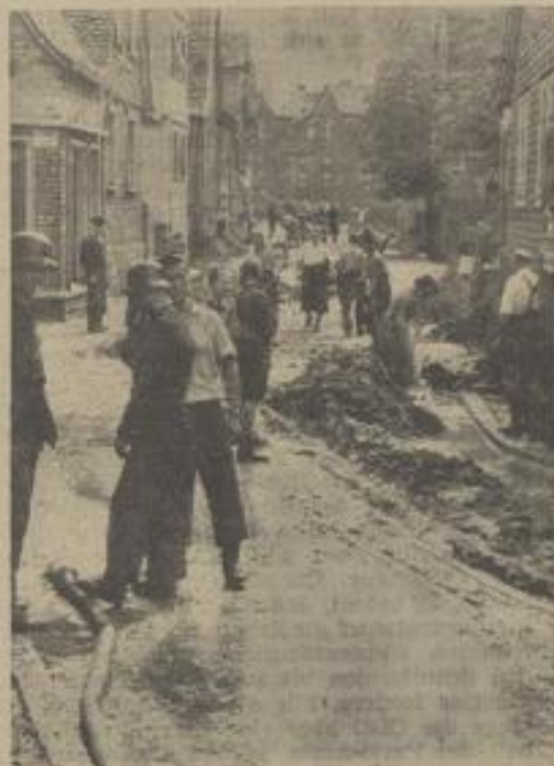
Einen noch nicht absehbaren Schaden richtete ein schweres Unwetter am Abend des 19. Mai im westlichen und südlichen Odenwald an. Unser Bild zeigt links Einwohner von Höchst, die in Selbsthilfe die Straßen der Stadt von den meterhoch liegenden Hagelkörnern und Schlammbergen befreien. Rechts: Durch Unterspülung wurde in die Bundesstraße 43 bei Höchst ein vier Meter tiefes Loch gerissen, so daß der Verkehr umgeleitet werden mußte. Foto: dpa
