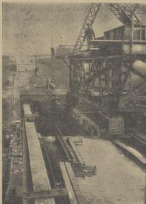
Der in den letzten Kriegstagen gesprengte Sulzbach-Autobahnviadukt wird jetzt, nachdem die langwierigen Abtragungsarbeiten der im Tal bei Denkendorf liegenden Trümmer beendet sind, wieder aufgebaut. Damit wird die letzte große Lücke der Autobahn Stuttgart-München geschlossen. Das umständliche und nicht ungefährliche Umfahren dieser Stelle wird auch bald wegfallen. Die Bauarbeiten an dem Viadukt werden sich auf etwa ein Jahr erstrecken. Unser Bild: Der erste Teil der neuen Stahlkonstruktion am westlichen Teil des Viadukts ist bereits angebracht. Auf der andern Talseite ist die Fortsetzung der Autobahn zu erkennen. Foto: Dpa
