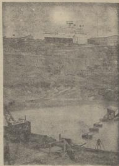
Ein Tunnel für 80 Millionen Gulden wird in Holland unter dem Nordsee-Kanal bei IJmuiden gebaut. Durch den etwa 3 Kilometer langen Tunnel, der bis 1956 fertiggestellt sein soll, werden eine Autostraße und eine Eisenbahnlinie gelegt — der Verkehr von Südholland nach dem Norden wird damit wesentlich vereinfacht werden. Unser Bild zeigt einen Blick auf die Baustelle, auf der nur 100 Arbeiter beschäftigt sind. Der größte Teil der Arbeiten wird von modernen Maschinen bewältigt. Im Vordergrund wird eine Grube ausgehoben, die das Fundament des Tunnels aufnehmen soll. Im Hintergrund passiert ein Hochseefrachter auf dem Nordseekanal die Baustelle.
