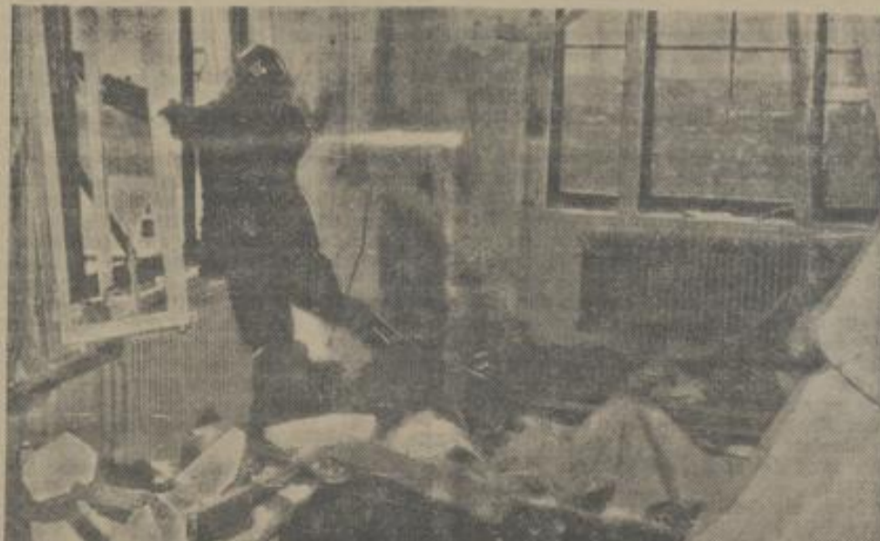
Das restlos zerstörte Zimmer im Verlagsgebäude der „Bremer Nachrichten“ nach dem Sprengstoff-Attentat. Chefredakteur Dr. Adolf Wolfard wurde bei der Explosion getötet, seine Sekretärin Helga Emmaus und der Redakteur Dr. Werner Wien schwer verletzt. Eine ähnliche Paketexplosion ereignete sich am gleichen Tage auf dem Postamt in Eyrstrup bei Verden, wobei eine Postangestellte getötet und vier weitere Personen verletzt wurden.
