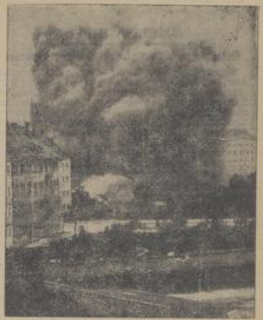
Noch am Freitag wurde die am Vortage bei Ausschachtungsarbeiten in Nürnberg gefundene 10-Ztr.-Luftmine, deren Zeitzünduhrwerk beim Auffinden der Mine zu ticken begonnen hatte, unter allen erdenklichen Vorsichtsmaßnahmen gesprengt. Die 8000 Nürnberger, die aus Sicherheitsgründen ihre Wohnungen hatten verlassen müssen, konnten in ihre Häuser zurückkehren. Unser Bild zeigt den riesigen Rauchpilz bei der Sprengung der Luftmine.
