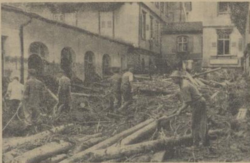
In Bad Rippoldsau stauten sich die angeschwemmten Holzmassen vor einem engen Straßendurchlaß
