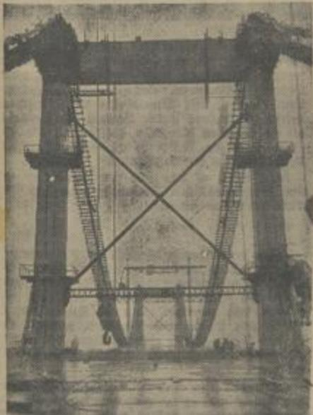
Der Wiederaufbau der während des Krieges zerstörten größten Hängebrücke Deutschlands, die Köln mit Köln-Mühlheim verbindet, geht seiner Vollendung entgegen. Länge: 485 m. Spannweite der frei schwebenden Tragekabel, die auf 50 m hohen Stahltürmen hängen: 315 m. Foto AP
