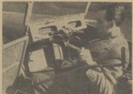
Die neuartige Lenkung und Montage der Bedienungshebel (sämtliche am Lenkungsgriff) ermöglichen vor allem Dingen dem Beinamputierten die Selbstlenkung des Fahrzeuges. Foto: Eugen Dod
