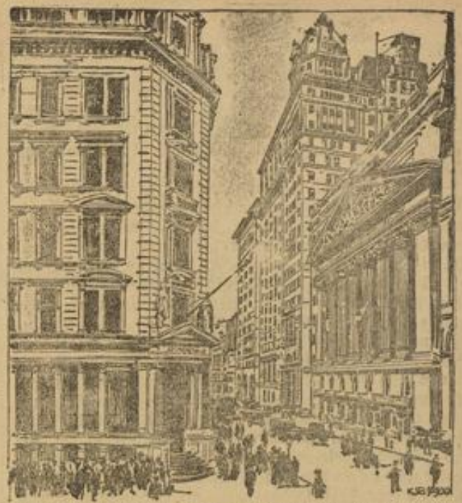
Der Eingang zur Wallstreet in New York, der Schauplatz der Explosion. Links das Morgangebäude, rechts die Börse.
