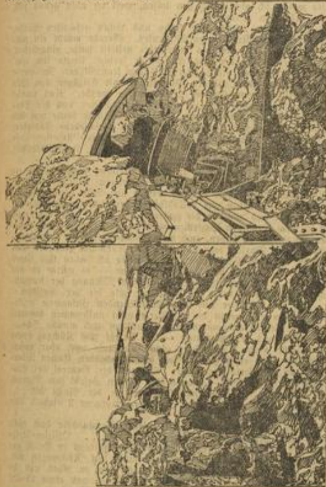
Darstellung der furchtbaren Wirkung des deutschen 42 cm-Belagerungsgeschützes, dessen Einzelschuß die stärkste Beton- und Panzerdecke durchbricht.
