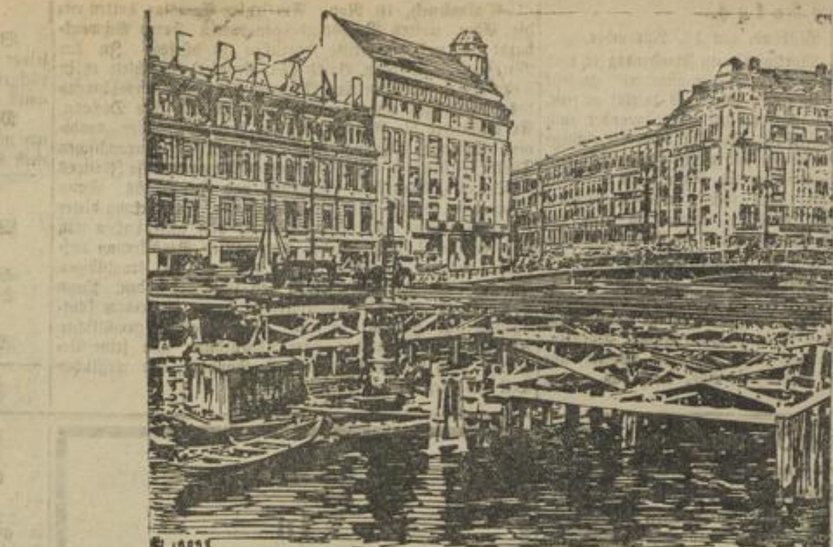
Groß-Berliner Schwebbahnbau: Holzbrücken an der Weidenhammer Brücke in Berlin.
