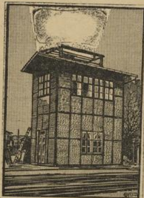
Der erste Leuchtturm für Luftschiffe. Die häufigen nächtlichen Leuchtungen der Militär- Luftschiffe haben die Errichtung von Leuchttürmen erforderlich gemacht. Der erste Leuchtturm wurde auf dem Spandauer Güterbahnhof improvisiert, indem man auf dem Dach 38 starke elektrische Lampen anbrachte, die in bestimmten Zwischenräumen aufleuchteten. Weitere derartige Leuchttürme sollen in Wauer und Potsdam folgen.
