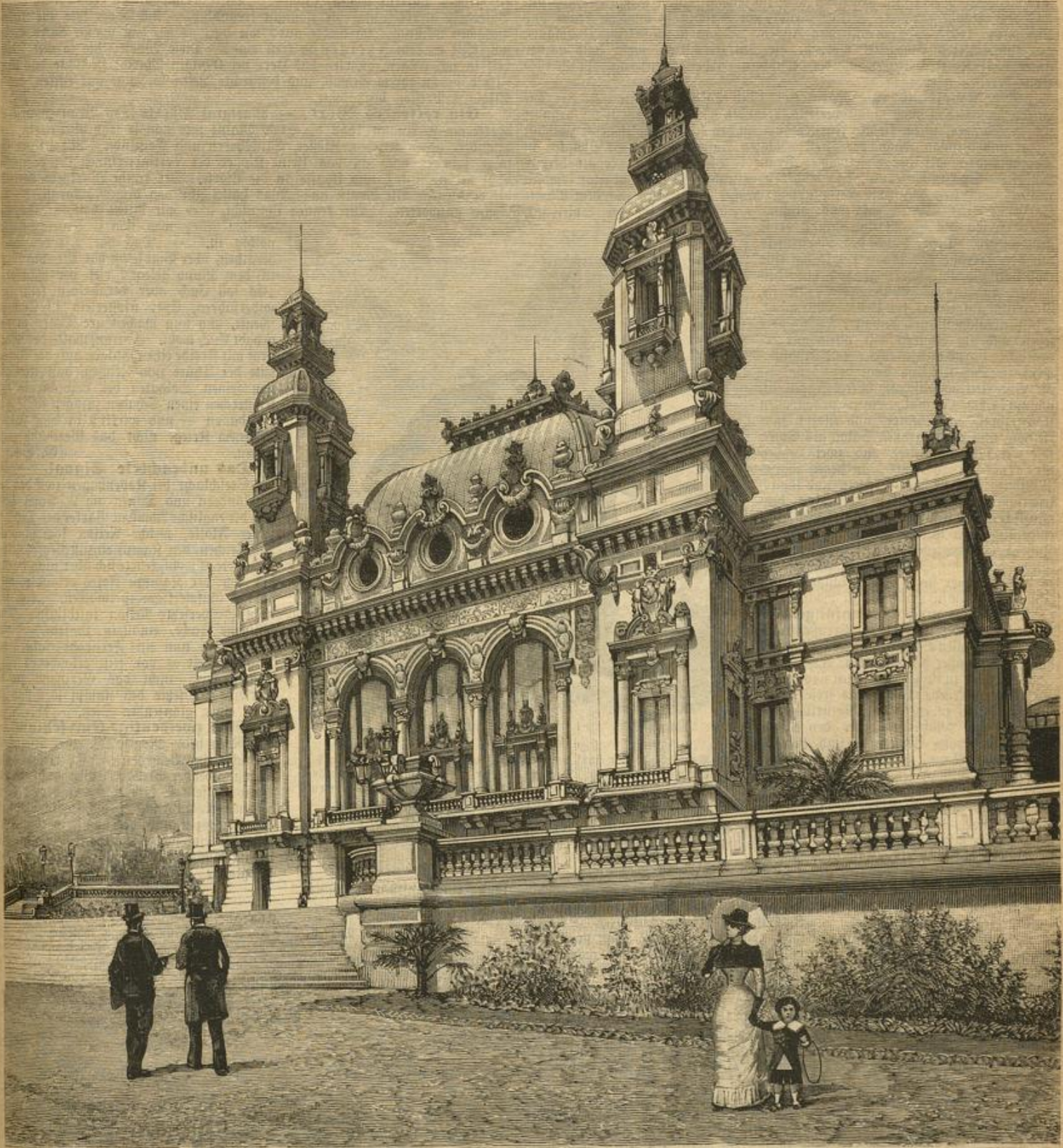
Das Gebäude der Spielbank auf Monte Carlo in Monaco. (S. 100)
