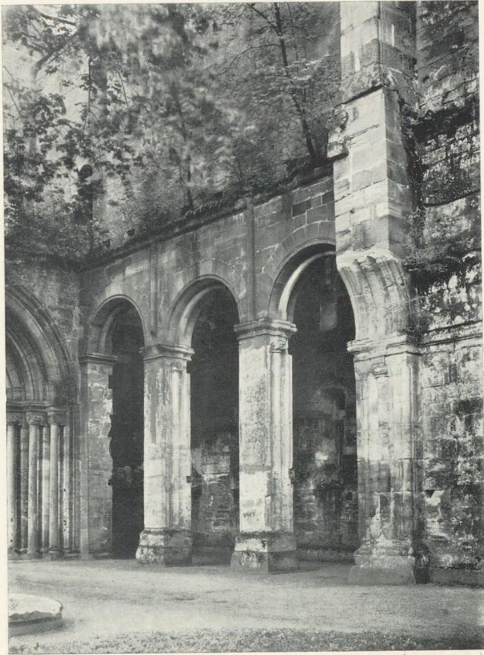
16. Paulinzella Südwand der ehem. Vorhalle
