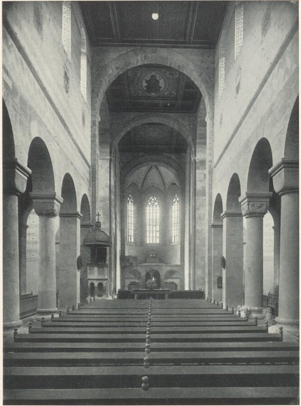
21. Alpirsbach Blick durch Langhaus gegen Osten
