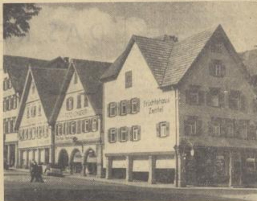
Alt-Freudenstadt — Giebelhäuser an der Ostseite des Marktplatzes
