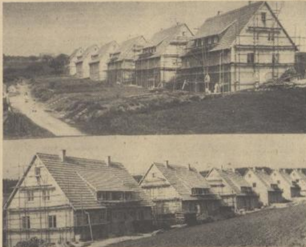
Die vordere und hintere Fassade der neuen Siedlung
