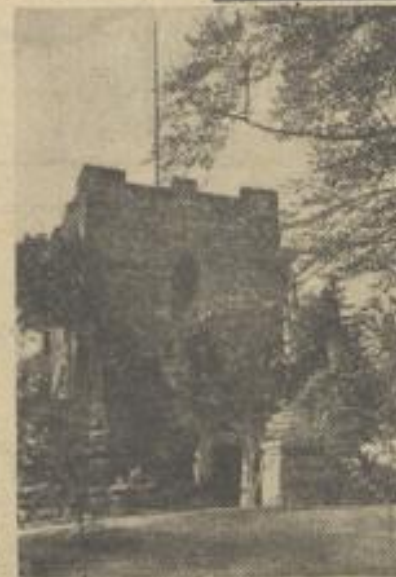
Das Kernerhaus von SW. aus gesehen. Es steht am Hügel, der von der Burg Weinsberg herunterläuft und in der Nähe der alten Staufenkirche. Den Vorbau hat der Dichter Kerner im Stile eines Schweizerhauses errichtet, der Turm wurde im späten 19. Jahrhundert von dem Sohn Theobald Kerner angebaut. Das Museum wurde Mitte Mai von Dr. Albert Walzer, Stuttgart, nach Entfernung aller neueren Requisiten in dem Originalstil neugeordnet. Der Geisterurm. Er wurde so genannt, weil hier die Seherin von Prevorst eine Zeitlang wohnte, deren Begabung für das Uebersinnliche Kerner entdeckt hatte. Der Turm ist ein Rest der alten staufischen Wehranlage. Der Altertümerammler Kerner hat in ihm auch u. a. Reste der Plastik vom Stuttgarter Lusthaus untergestellt.
