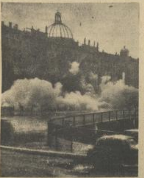
Auf Befehl des Ostmagistrats wird das gesamte Berliner Schloß gesprengt, und an seiner Stelle sollen in Zukunft das Regierungsgebäude und ein großer Aufmarschplatz entstehen. Die erste Sprengung ist bereits erfolgt. Foto: Ap
