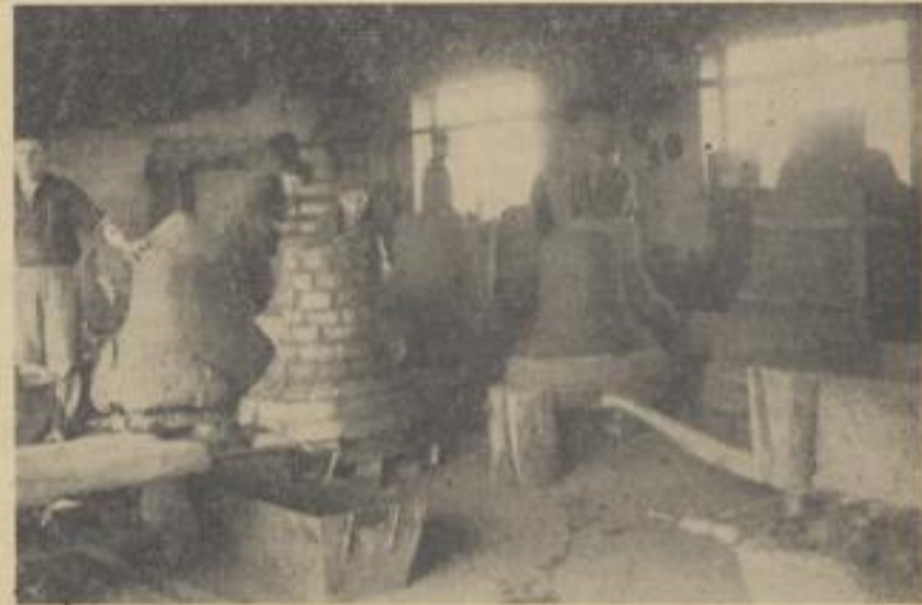
Die Glockenmodelle werden sorgfältig aufgemauert
