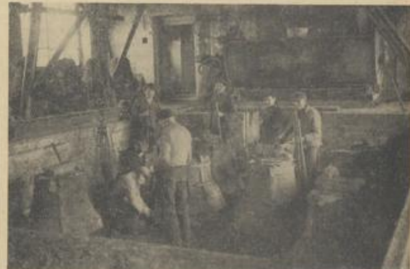
In der Gußgrube erhalten die Glockenkern die Glockenmantel
