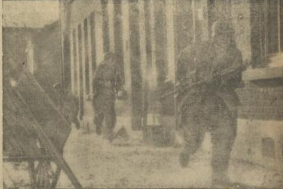
An den Mauern
