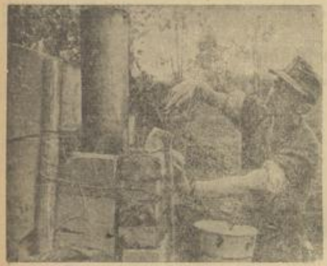
Gleich wird der „Schornstein“ rauchen und einigen Kieselsteinen, einem Osenrohr und etwas Lehm in die Erde für den Funkenofen entsandt. Die irdischen Stellen werden verputzt. Vgl. Aufnahme: Kriegsbericht Jacob (Wb).
