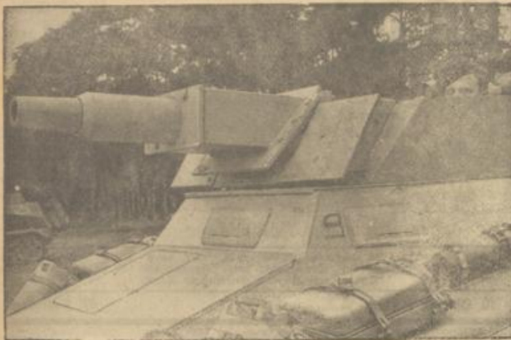
Stark bewaffnete Panzerpflanzwagen Die Hauptaufgabe der Panzerpflanzwagen liegt in der schnellen und genauen Erkundung der Stärke und des Standortes des Gegners. Doch ist bei Feindberührung ein Kampf oft unvermeidlich, insbesondere sind Panzer und Pakstellungen auszufüllen, wofür diese 7,5-cm-Kanone eines Acht-Panzerpflanzwagens besonders geeignet ist. (P.A.-Aufnahme: Kriegsberichtler Kempf, III., M.)
