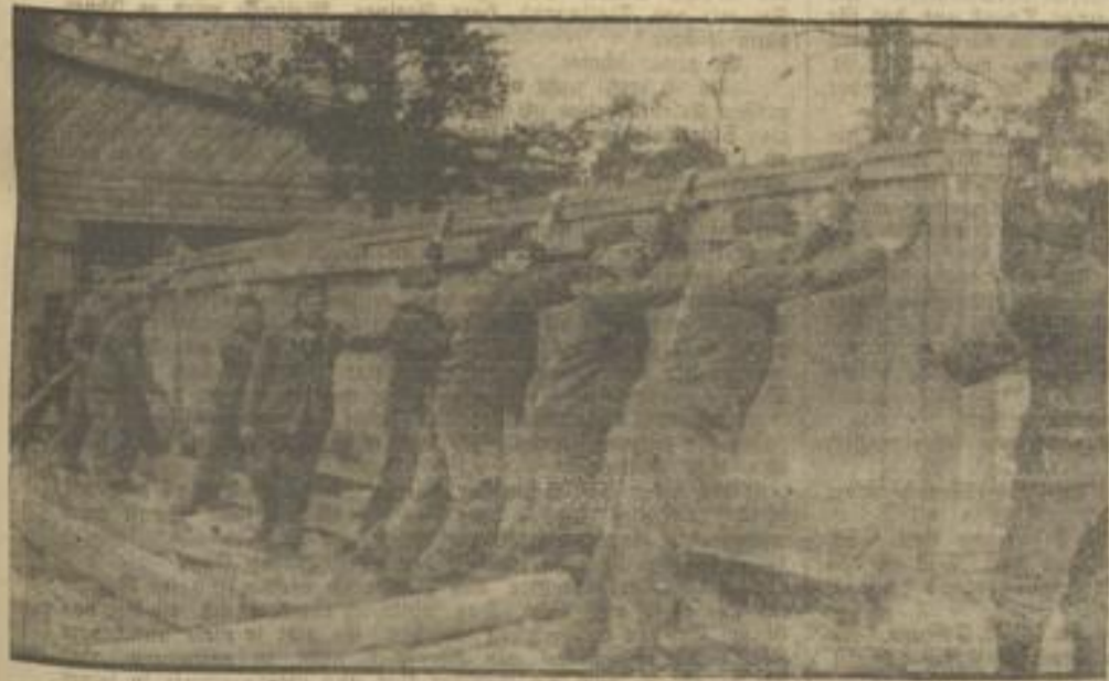
Holz statt Eisen — auch beim schweren Brückenbau
