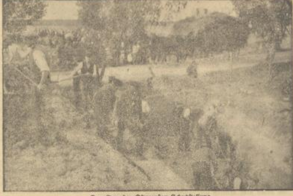
Der Bau der Ostpreußen-Schutzstellung
