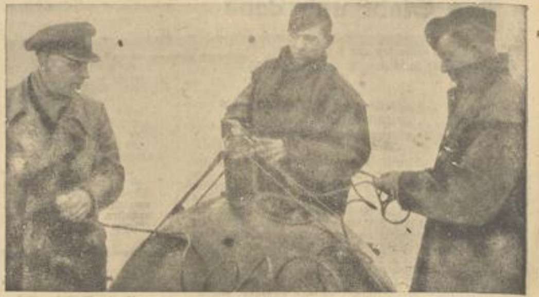
Diese Mine kann wegen ihrer Lage auf einem bei Flut meist überspülten Sand nicht abtransportiert werden. Deshalb wird eine Sprengladung angehängt. (PK-Aufnahme: Kriegsberichtler Hirsche, PDS, M.)
