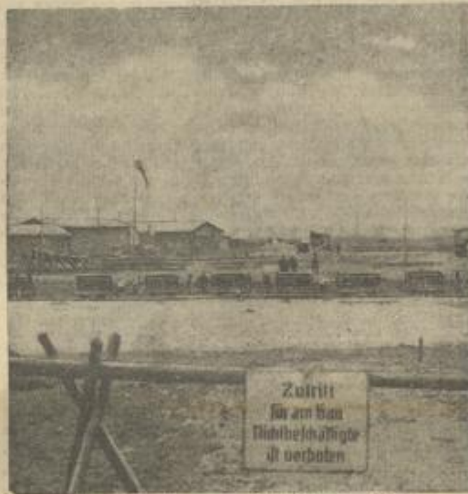
Wo Hitler die neue Arbeitschlacht eröffnet. Von der Baustelle Unterhaching bei München wird der Kanzler Adolf Hitler mit einer über alle deutschen Sender gehender Rede die neue große Arbeitschlacht eröffnen.
