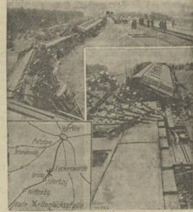
Das Attentat am D-Zug Basel-Berlin Durch ein äußerst raffiniertes Attentat ist am Sonnabend der D-Zug Basel-Berlin zwischen den Stationen Gröna und Ludenwalde zur Entleistung gebracht worden. Unser Bild zeigt links oben; die von der Bahnböschung hinabgestürzten Wägen, rechts das Gewirr der verführten Telegraphenleitungen. Links: Die Unfallstelle.
