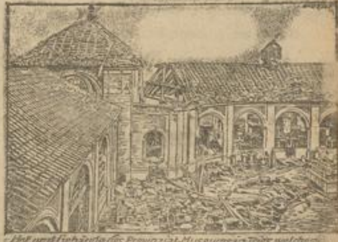
Das ist ein Teil des Provinzial-Museums in Trier, welches durch einen Bombenangriff am 1. September 1918 zerstört wurde.
