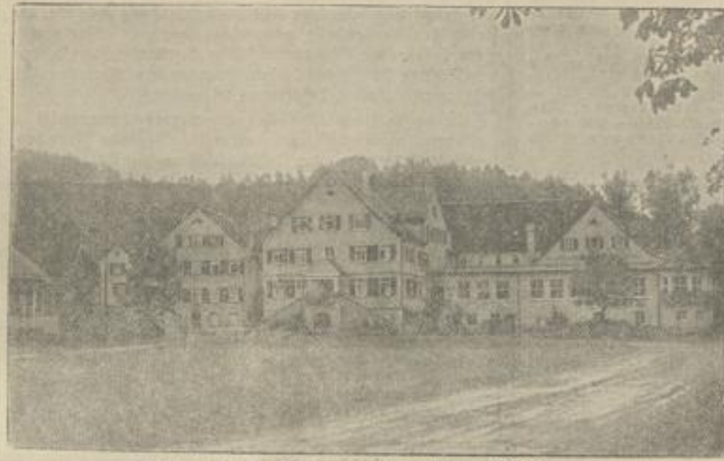
Selbstansicht des Handwerker-Erholungsheims Bad Niedernau
