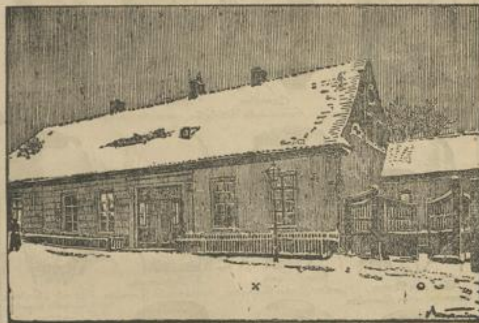
Jur Allensteiner Nordaffäre: Villa Schoenebeck. X Schlafzimmer des Ermordeten. O Der vermutlich vom Mörder benutzte Ausgang.
