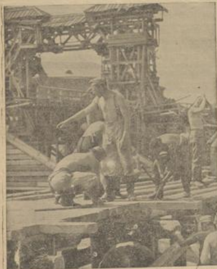
Auch hier errichteten deutsche Pioniere in überraschend kurzer Zeit eine Brücke, die selbst schweren Lasten sicheren Uebergang gewährte
