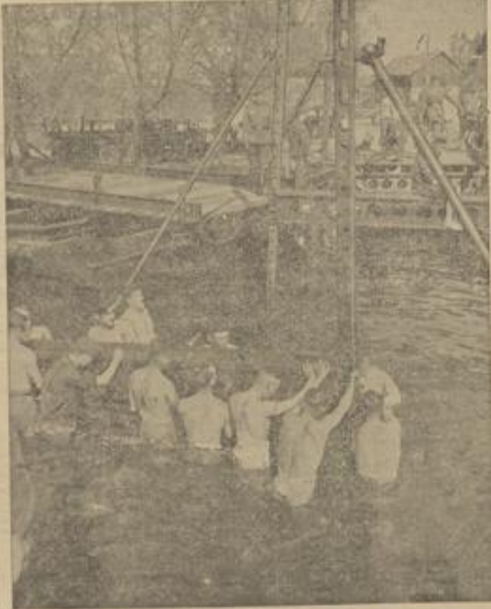
Der Brückenbau geht ebenso schnell wie sicher vonstatten. — Das Bild zeigt die Brückenkolonne beim Aufrichten des Bodens
