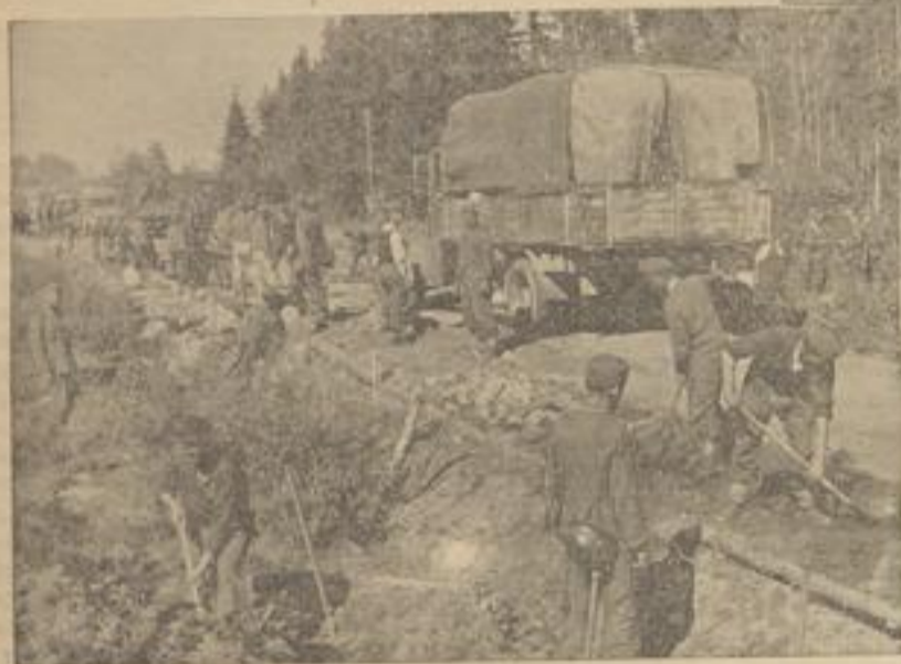
Pioniere arbeiten an der Fertigstellung der Anlagestelle einer Fähre, auf der die schweren Waffen über den Fluß geschafft werden können
