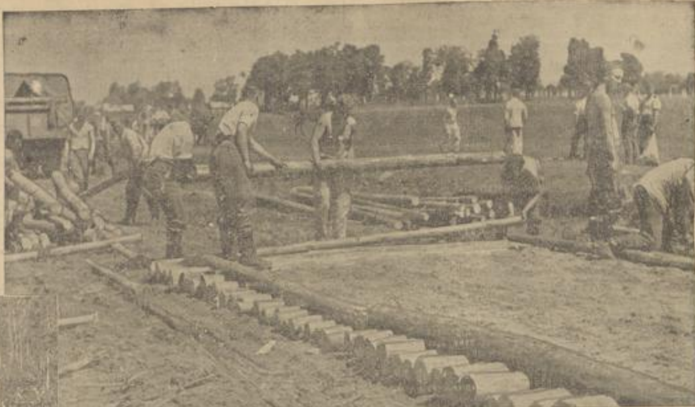
Pioniere beim Bau eines Knüppelbammes auf grundlosen Wegen
