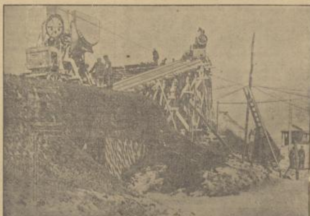
Bunkerbau an der Kanalstraße Beton-Mischmaschinen werden auf einer Gleisbahn auf das Gerüst geschafft. B.-A. Aufnahme: Kriegsberichterstatter Enselmeier (WB.)
