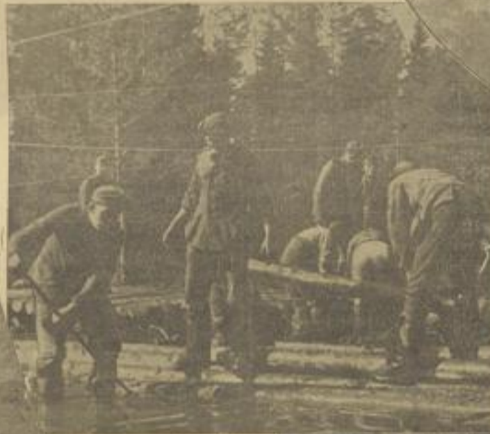
Über grundlosen Weg errichten unsere Pioniere einen Knüppeldamm
