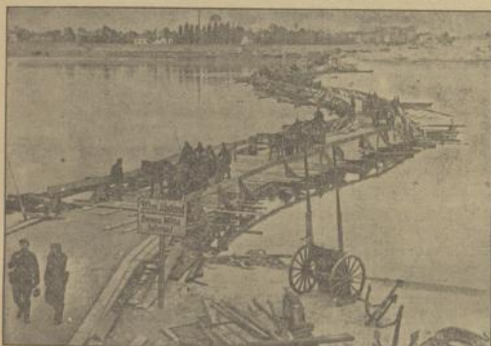
Holzbrücke über den Dnjepr. K.A.-Pintcher-Weltbild (M.) Wie ein Wurm schlängelt sich die aus vielen Flößen zusammengesetzte Brücke über den Strom.
