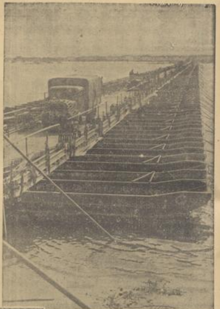
Links: Kriegsbrückenbau im Osten. Nachdem die Konstruktion steht, wird der Bohlenbelag aufgetragen. Rechts: Eine Fangerdwinde fest über den Dnjepr. Diese Schiffsbrücke wurde noch von den Kampfpionieren in wenigen Tagen erbaut. Die Brückenbaupioniere werden an dieser Stelle eine feste Brücke errichten. Unten: Eine Brückenbaukompanie bei der Arbeit.
