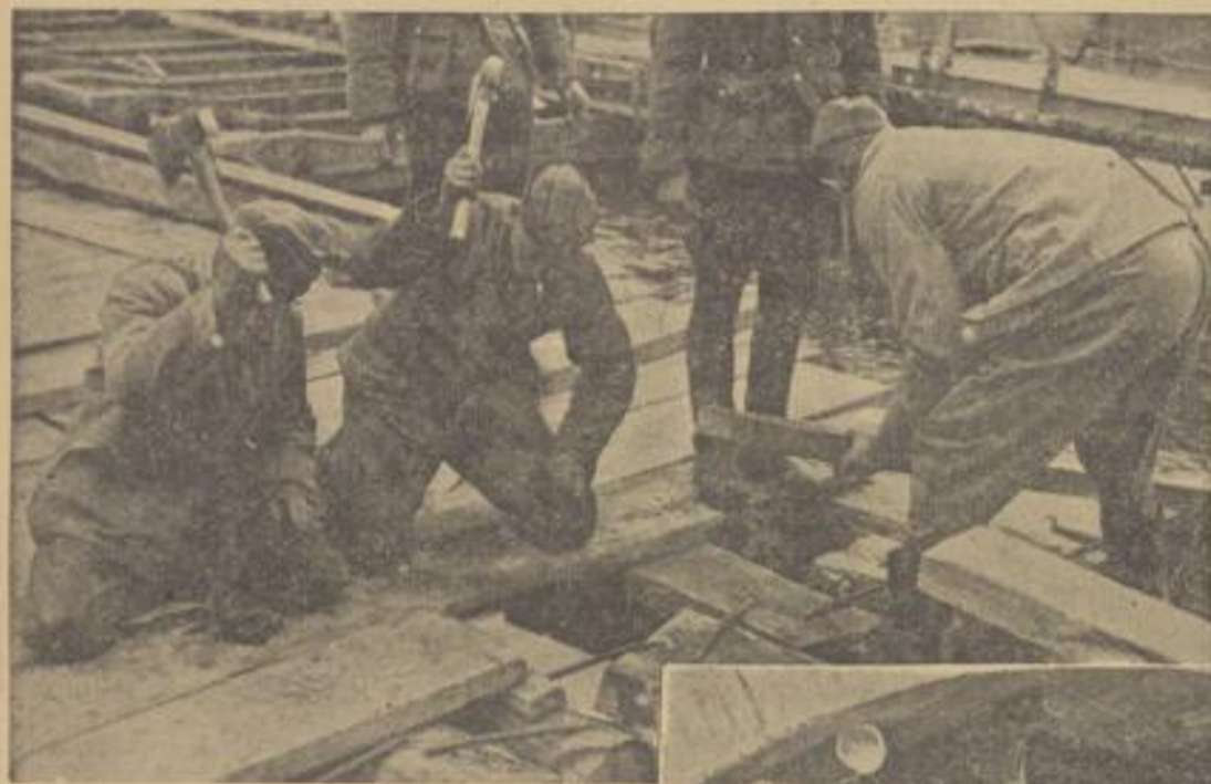
Links: Kriegsbrückenbau im Osten. Nachdem die Konstruktion steht, wird der Bohlenbelag aufgetragen. Rechts: Eine Fangerdwinde fest über den Dnjepr. Diese Schiffsbrücke wurde noch von den Kampfpionieren in wenigen Tagen erbaut. Die Brückenbaupioniere werden an dieser Stelle eine feste Brücke errichten. Unten: Eine Brückenbaukompanie bei der Arbeit.
