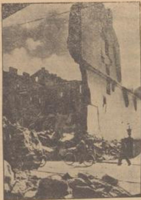
Eine Aufnahme aus Minsk. Hier blieb von einem Haus nur noch die hohe Hauswand stehen. FR. Bauer-Weltbild (M.)
