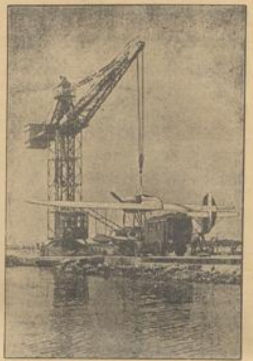
Das Flugzeug am Kran.
