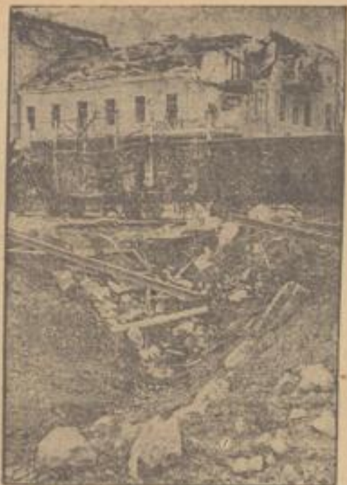
Reste einer Stuka-Bombe, die Gieissanlagen, Waggon und Bahnhofsgebäude zerstörte. Dr. Gagenz Weistbild (M.)
