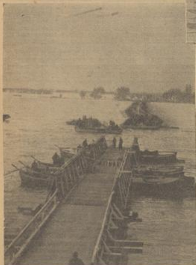
1100 Mann einer ostmärkisch-schlesischen Pioniereinheit haben nur wenige Wochen an dieser Brücke gebaut. Der Bau ging so vor sich, daß ein am Ufer vordereitetes „Doppelgespann“ nach dem anderen in die richtige Lage geschleppt und alles untereinander fest verbunden wurde. Oben: Ein Teilstück der Brücke, ein „Doppelgespann“ wird eingefahren und (links) das letzte Stück einer Donaubrücke wird eingeschleppt. Rechts: Auflegen der Ankerketten, eine Arbeit, die von besonderer Wichtigkeit für die sichere Lage der Brücke ist. Unten: Rumänische Fischer legen die Velleitung über die Brücke. Photo: R. Schulz (Mitl.), Pst. Koch (W.R.), R. Die (Scherl), R. Stahl (Weltbild) — W.
