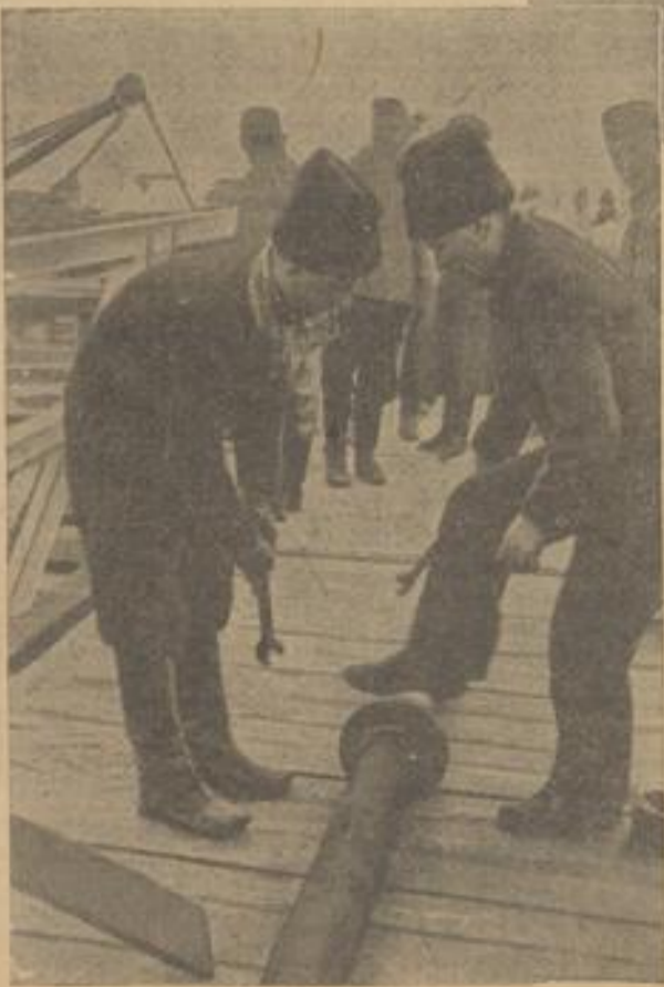
1100 Mann einer ostmärkisch-schlesischen Pioniereinheit haben nur wenige Wochen an dieser Brücke gebaut. Der Bau ging so vor sich, daß ein am Ufer vordereitetes „Doppelgespann“ nach dem anderen in die richtige Lage geschleppt und alles untereinander fest verbunden wurde. Oben: Ein Teilstück der Brücke, ein „Doppelgespann“ wird eingefahren und (links) das letzte Stück einer Donaubrücke wird eingeschleppt. Rechts: Auflegen der Ankerketten, eine Arbeit, die von besonderer Wichtigkeit für die sichere Lage der Brücke ist. Unten: Rumänische Fischer legen die Velleitung über die Brücke. Photo: R. Schulz (Mitl.), Pst. Koch (W.R.), R. Die (Scherl), R. Stahl (Weltbild) — W.
