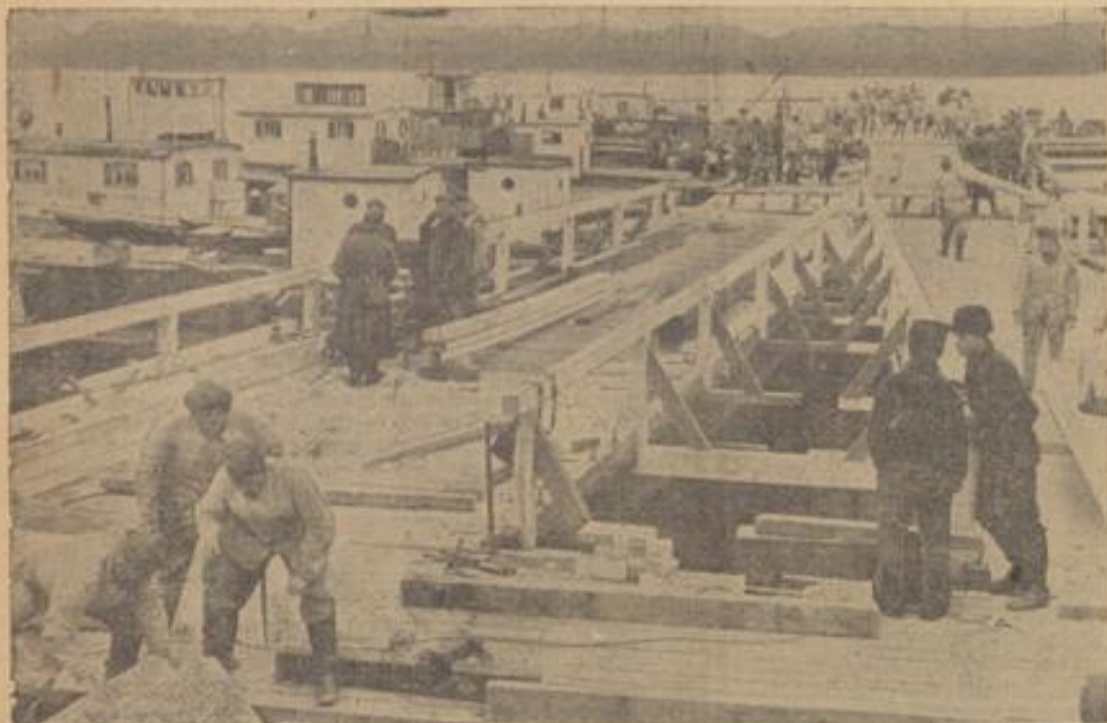
Rechts: Das fertige Werk. Bild aus dem Flugzeug auf die mächtige Donaubrücke, die von einer ostmärkisch-schlesischen Pioniereinheit über die Donau gebaut wurde. Die schweren Holzbohlen und Eisenträger liegen auf breiten Rähnen. Links: Die Fahrbahn wird bei dem „Trompetensüß“ fertiggestellt. Im Hintergrund die beim Bau verwendeten Schlepper.
