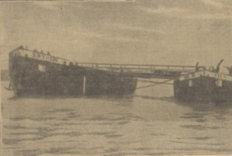
1100 Mann einer ostmärkisch-schlesischen Pioniereinheit haben nur wenige Wochen an dieser Brücke gebaut. Der Bau ging so vor sich, daß ein am Ufer vordereitetes „Doppelgespann“ nach dem anderen in die richtige Lage geschleppt und alles untereinander fest verbunden wurde. Oben: Ein Teilstück der Brücke, ein „Doppelgespann“ wird eingefahren und (links) das letzte Stück einer Donaubrücke wird eingeschleppt. Rechts: Auflegen der Ankerketten, eine Arbeit, die von besonderer Wichtigkeit für die sichere Lage der Brücke ist. Unten: Rumänische Fischer legen die Velleitung über die Brücke. Photo: R. Schulz (Mitl.), Pst. Koch (W.R.), R. Die (Scherl), R. Stahl (Weltbild) — W.
