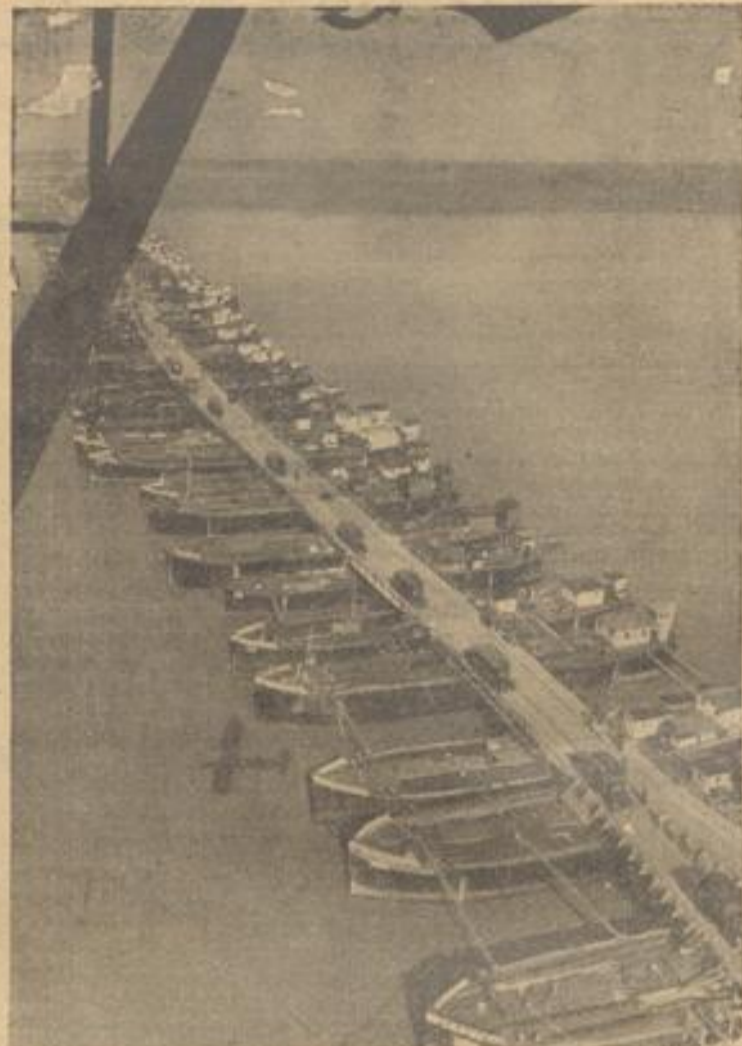
Rechts: Das fertige Werk. Bild aus dem Flugzeug auf die mächtige Donaubrücke, die von einer ostmärkisch-schlesischen Pioniereinheit über die Donau gebaut wurde. Die schweren Holzbohlen und Eisenträger liegen auf breiten Rähnen. Links: Die Fahrbahn wird bei dem „Trompetensüß“ fertiggestellt. Im Hintergrund die beim Bau verwendeten Schlepper.
