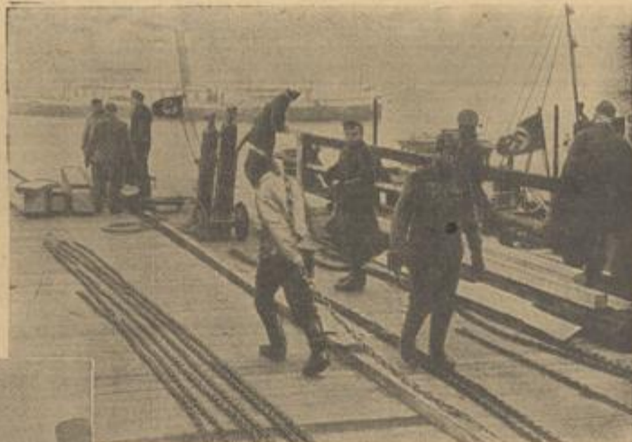
1100 Mann einer ostmärkisch-schlesischen Pioniereinheit haben nur wenige Wochen an dieser Brücke gebaut. Der Bau ging so vor sich, daß ein am Ufer vordereitetes „Doppelgespann“ nach dem anderen in die richtige Lage geschleppt und alles untereinander fest verbunden wurde. Oben: Ein Teilstück der Brücke, ein „Doppelgespann“ wird eingefahren und (links) das letzte Stück einer Donaubrücke wird eingeschleppt. Rechts: Auflegen der Ankerketten, eine Arbeit, die von besonderer Wichtigkeit für die sichere Lage der Brücke ist. Unten: Rumänische Fischer legen die Velleitung über die Brücke. Photo: R. Schulz (Mitl.), Pst. Koch (W.R.), R. Die (Scherl), R. Stahl (Weltbild) — W.
