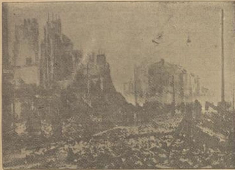
Eine zerstörte Straße in Southampton. Wirkungen eines deutschen Luftangriffs auf die wichtige britische Hafenstadt. Weltbild (W).
