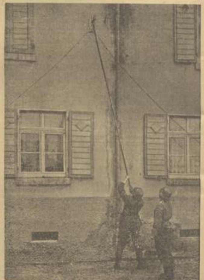
Der Mann mit der Drahtgabel nutzt einen Stützpunkt am Haus aus
