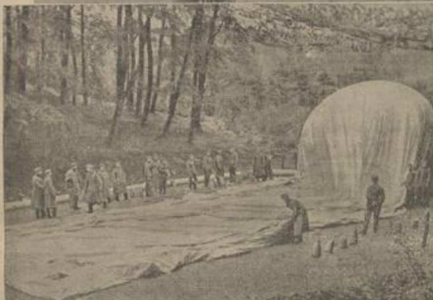
Oben: Die ausgedehnte Ballonhülle wird gefüllt. — Unten: Die Füllung mit Wasserstoffgas ist beendet.
