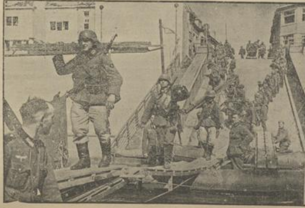
Pioniere beim Bau eines Notbrücke. Die von den flüchtenden Holländern gesprengte Brücke bei Maastricht bildete kein Hindernis für den Vormarsch unserer Truppen. Pioniere und Bautrupps haben schnell eine Notbrücke errichtet. (A. Reichbild (M))
