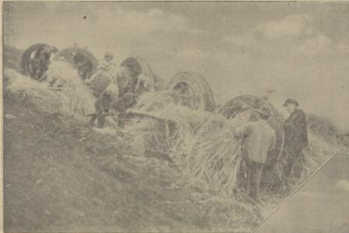
Links: Wenn die Balken gefügt sind, wird Strohbündel auf Strohbündel zwischen die Speichen gesteckt.
