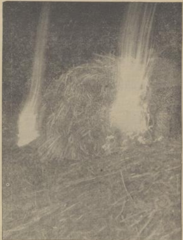
Links: Wenn die Balken gefügt sind, wird Strohbündel auf Strohbündel zwischen die Speichen gesteckt.
